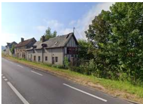
Vue du site depuis la route départementale D915 (Geostudio)
