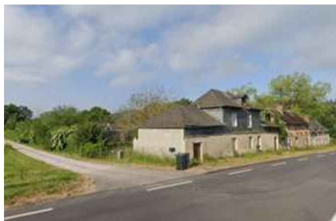
Vue du site depuis la route départementale D915 (Geostudio)
