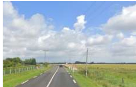
Tronçon routier limité à 50 km/h en direction de Dieppe. Le site d'OAP est sur la droite.
