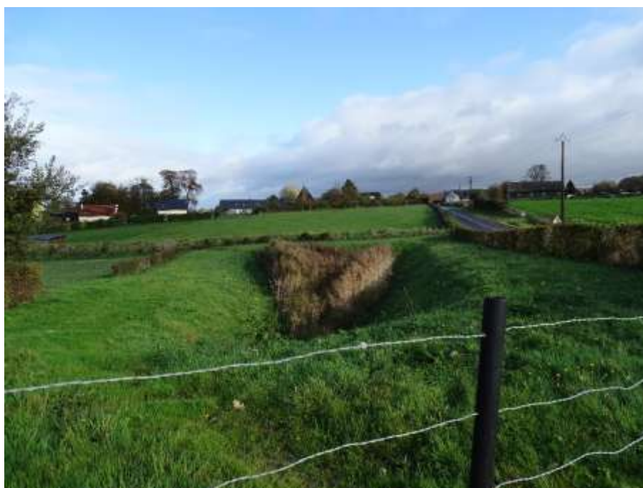
Photo 38 : Bassin routier à Gonnetot – Source : 2AD
