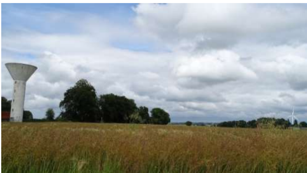
Photo 79 : Château d'eau de Lestanville et éolienne à Saint-Pierre-Bénouville
