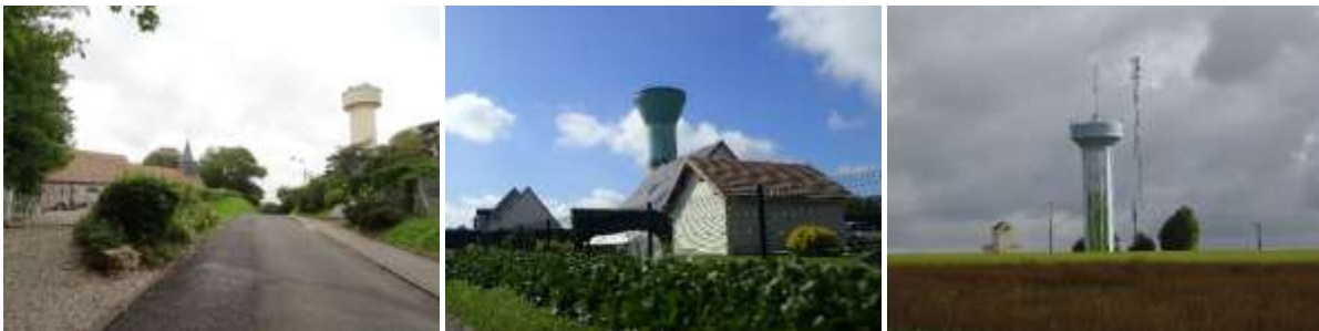
Photo 76 : Châteaux d'eau de Quiberville-sur-Mer, Belleville-en-Caux et Lintot-les-Bois
