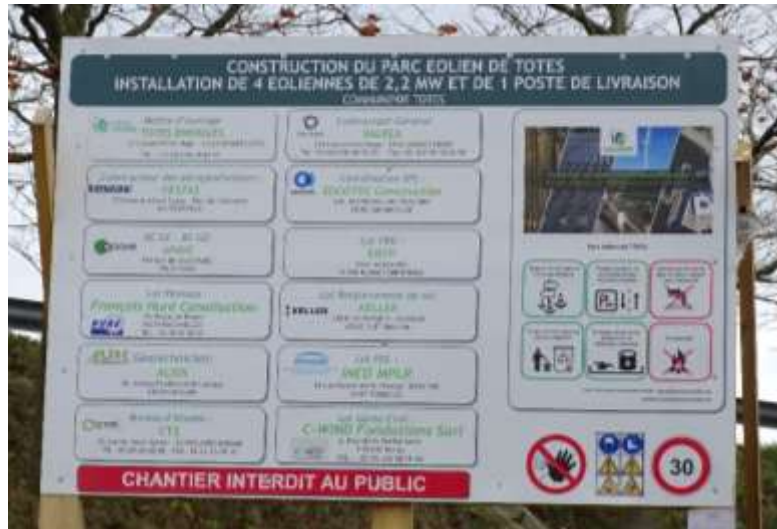
Photo 34 : Panneau d'information de construction du parc éolien de Tôtes – Source : 2AD
