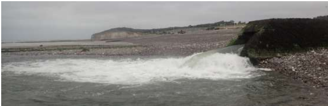
Photo 27 : Epibuse (exutoire de la Saône) à Quiberville-sur-Mer – Source : GAMA Environnement
