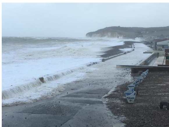
Figure 38 Franchissement par paquet de mer engendrant des dommages aux infrastructures sur la route digue de Sainte-Marguerite-sur-Mer et Quiberville. J.Favrel 2018
