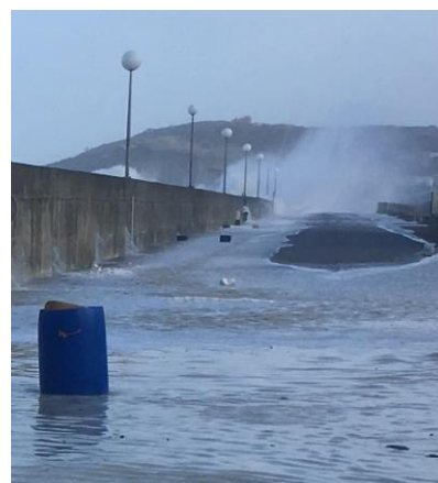
Figure 38 Franchissement par paquet de mer engendrant des dommages aux infrastructures sur la route digue de Sainte-Marguerite-sur-Mer et Quiberville. J.Favrel 2018
