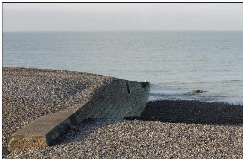
Figure 44 Accumulation de galets à l'Est du dernier épi de Sainte-Marguerite-sur-Mer, décembre 2017 (Cerema NC)
