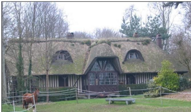
Constructions à pans de bois avec colombes apparentes verticales et serrées, hourdées de torchis recouvert d'enduit blond ocré. Toiture végétale en chaume avec « queue de geai » abritant l'échelle de meunier. Faîtage en terre planté d'iris, de sédum et de joubarbe.
