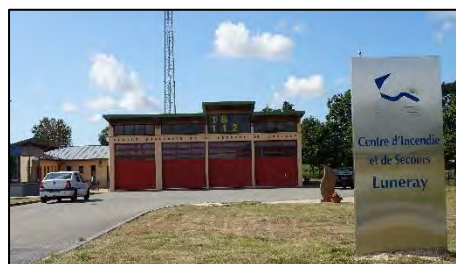
Centre d'incendie et de secours de Val-de-Scie (haut) et Luneray (bas) (Source : Géostudio, 2AD & GAMA)
