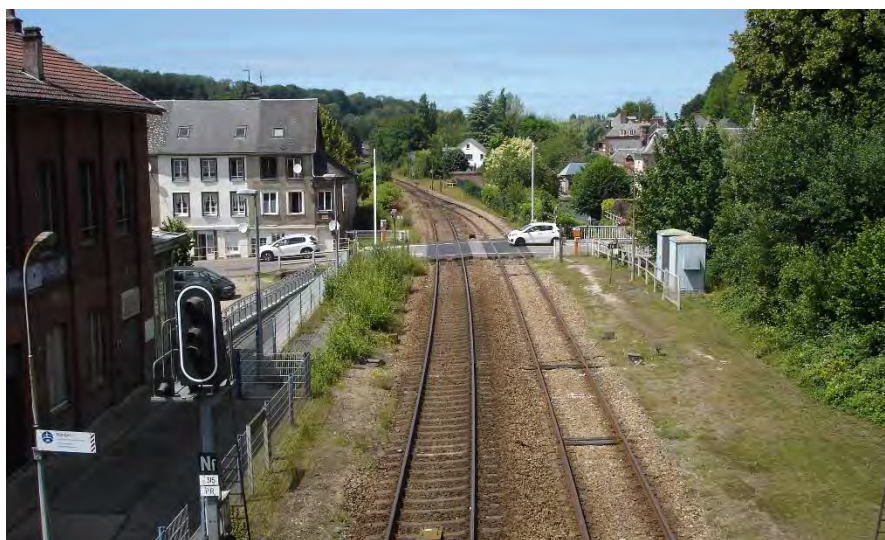
Photo 4 : Voie ferrée au niveau de la gare de Longueville-sur-Scie
