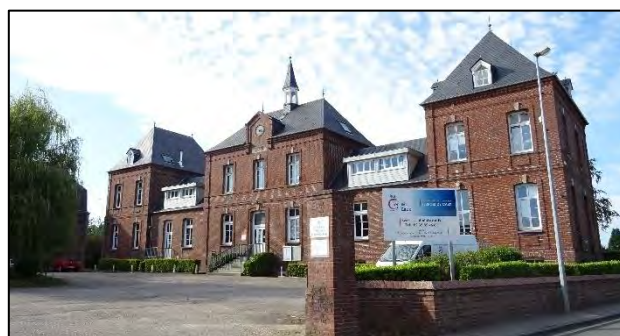
Siège de la CC Terroir de Caux (Source : Géostudio & 2AD)
