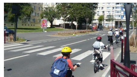
Voie principale en zone 30 équipée d'une bande cyclable
