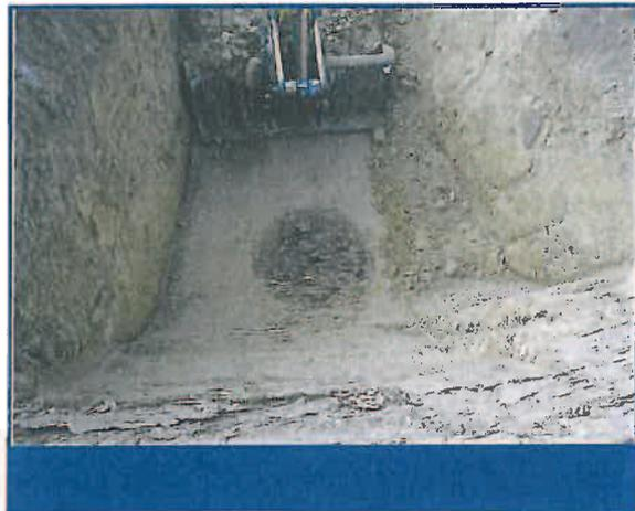
**Photo 4 (vues a et b) : Ancien puits en fond de fouille**
