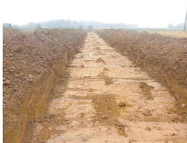
**En revanche, en ce qui concerne l'indice parcellaire 76721-06, une zone de remblai limoneux parfaitement circulaire de 1 m de diamètre a été mise en évidence ; cette zone persistante en profondeur correspond à un ancien puits d'accès à une carrière souterraine et donc potentiellement à la carrière déclarée.**
