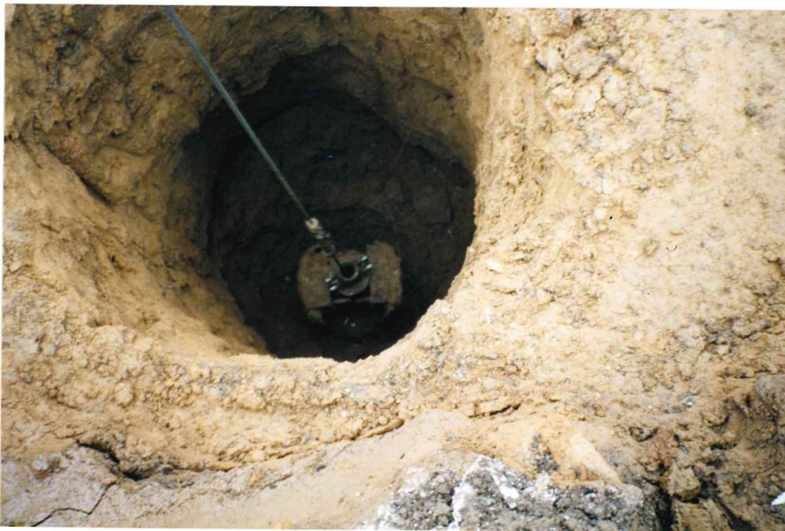
(- Photo n° 3, vu du curage du puits, diamètre de 3.50m )
