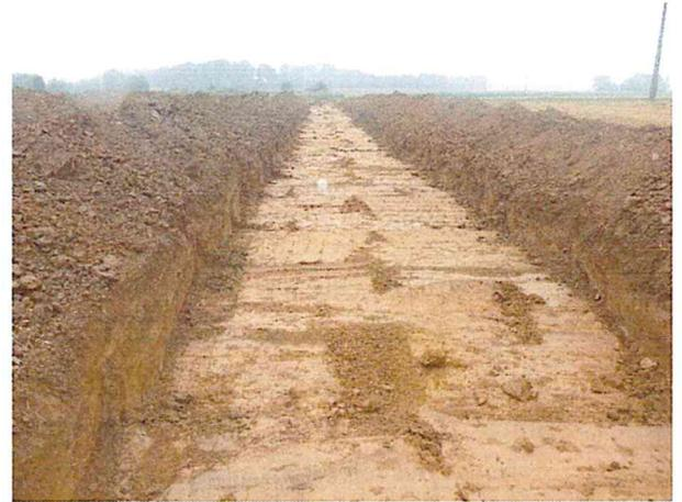
**En revanche, en ce qui concerne l'indice parcellaire 76721-06, une zone de remblai limoneux parfaitement circulaire de 1 m de diamètre a été mise en évidence ; cette zone persistante en profondeur correspond à un ancien puits d'accès à une carrière souterraine et donc potentiellement à la carrière déclarée.**
