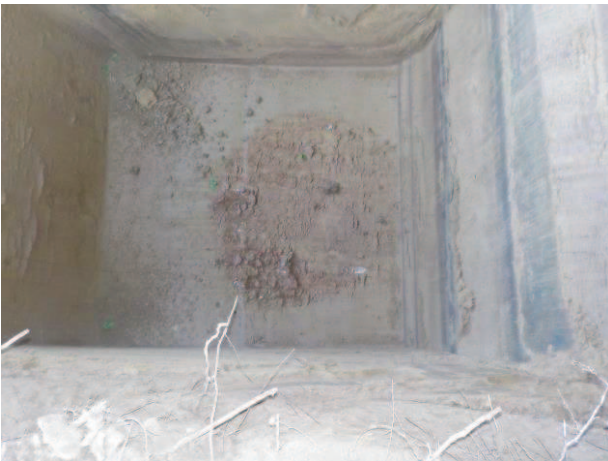
Photographie 25 : Persistance de l'anomalie (ICS 242) composée d'argile en fin de décapage à 2,5m
