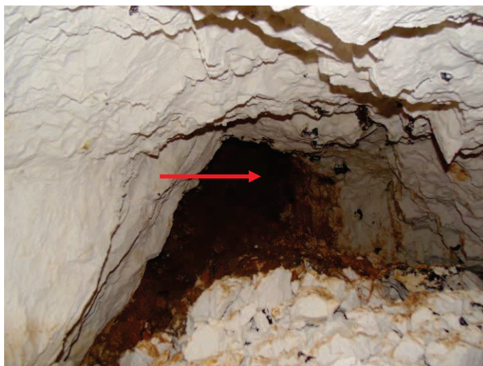
Photographie 2 : Forage d'évent (cavité 241)
