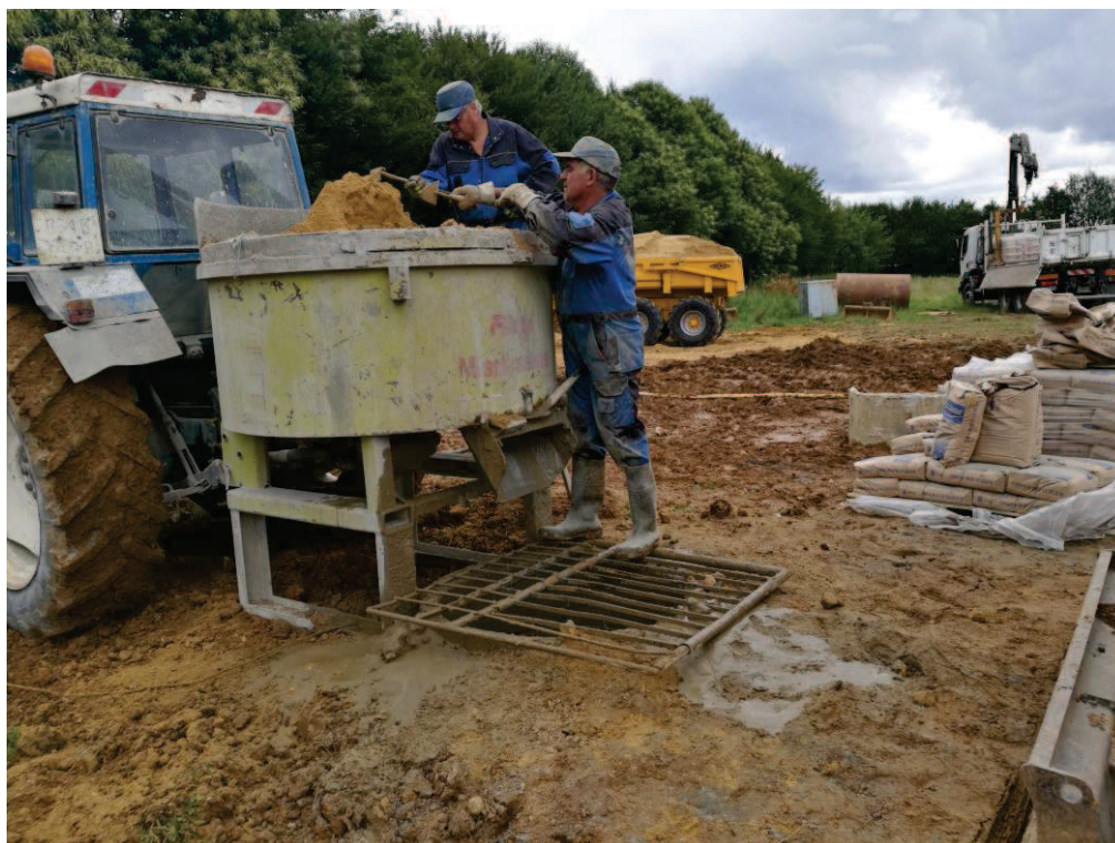
Photographie 3 : Illustration de la préparation du coulis béton pour le comblement
