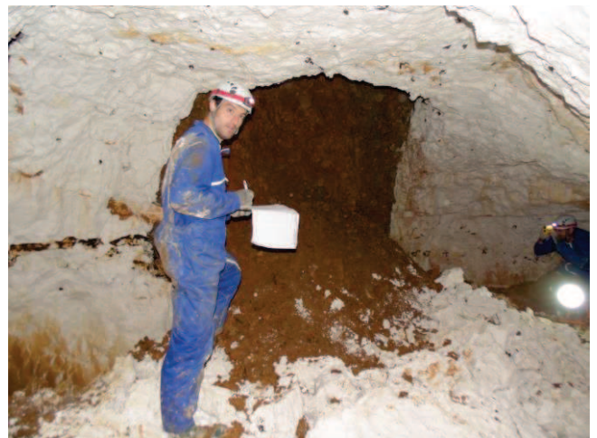
Photographie 10 : Autre effondrement important de matériaux (formations limoneuses et argileuses)
