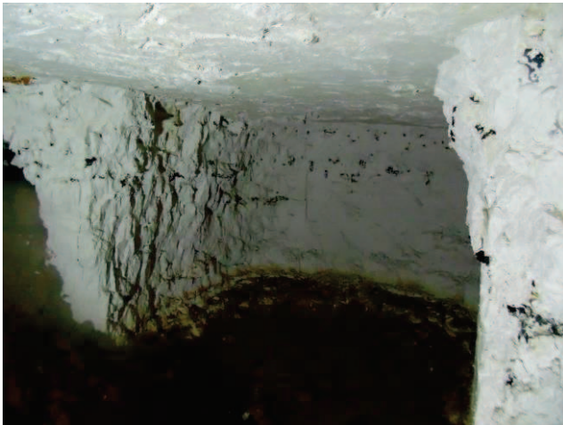
Photographie 7 : Galerie d'exploitation de marne (1/2)
