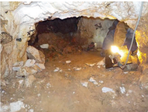
Photographie 1 : Puits et chambre de marnière
