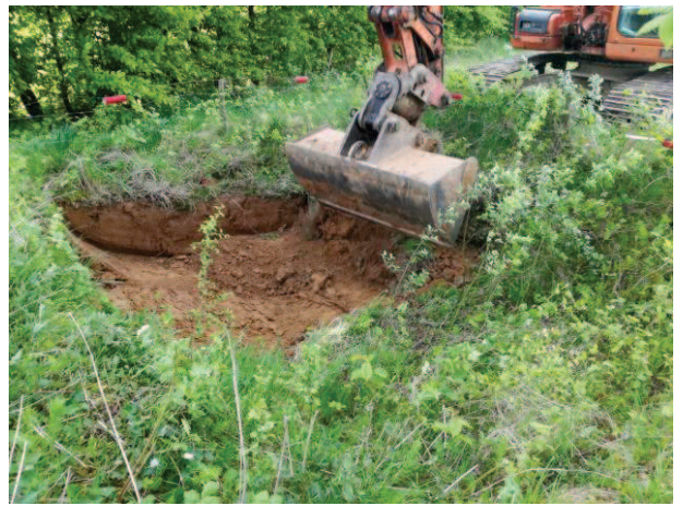
Photographie 2 : Première tranchée à l'aide d'un godet cureur
