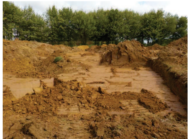
Photographie 26 : Vue d'ensemble du site en fin de décapage
