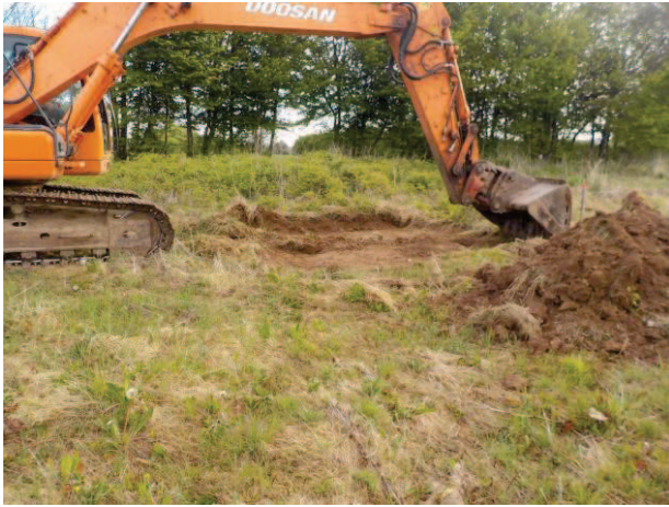
Photographie 11 : Vue du site d'étude au début du chantier/godet cureur
