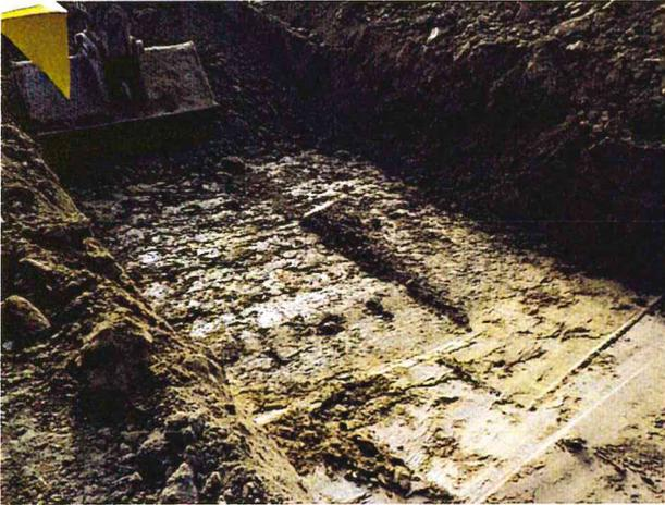
**Photographie 1 : Décapage par lames de 0,20 à 0,30m au godet cureur**
