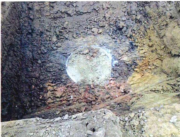
**Photographie 3 : Indice 122- Puits de marnière bétonné**
