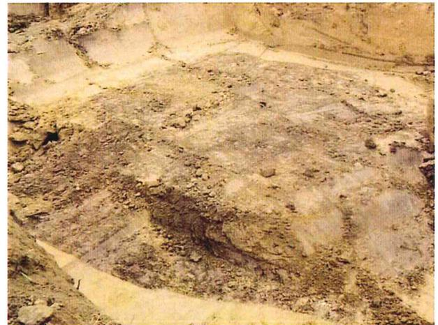
**Photographie 4 : Indice 123 -Anomalie de remblais - Effondrement supposé d'une chambre de la cavité souterraine**
