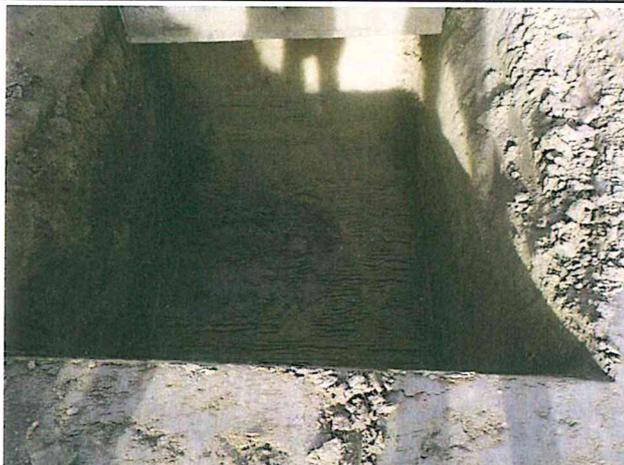
**Photographie 9 : Puits de marnière composé de limon brun foncé au sein du limon jaunâtre**
