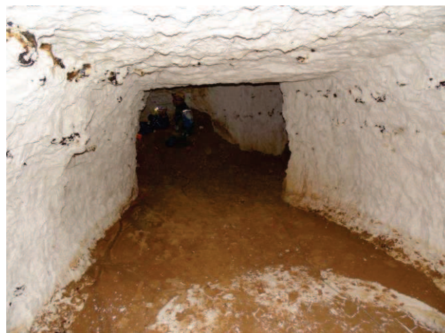
Photographie 8 : Couloir principal d'exploitation de marne
