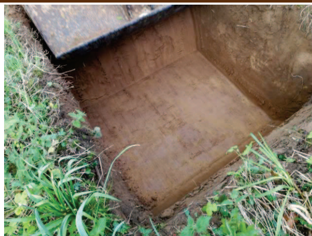
Photographie 10 : Disparition de l'anomalie de remblais en fin de décapage à 1,3m de profondeur
