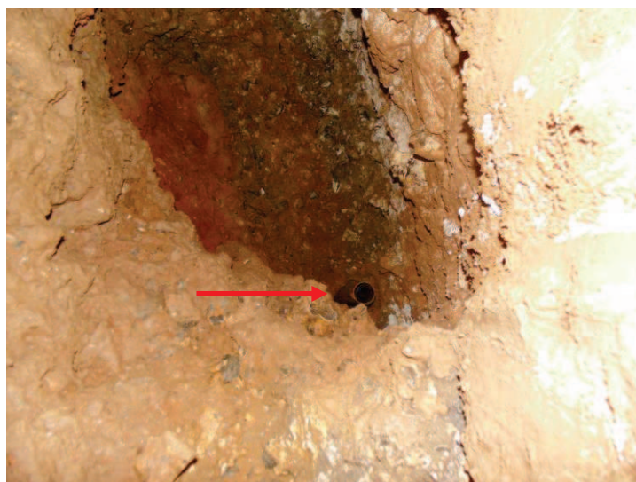
Photographie 1 : Forage d'évent (cavité 51)
