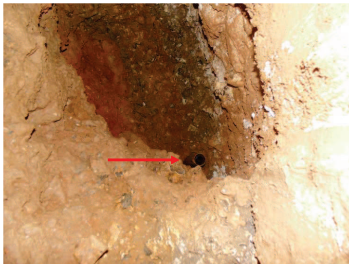
Photographie 1 : Forage d'évent (cavité 51)
