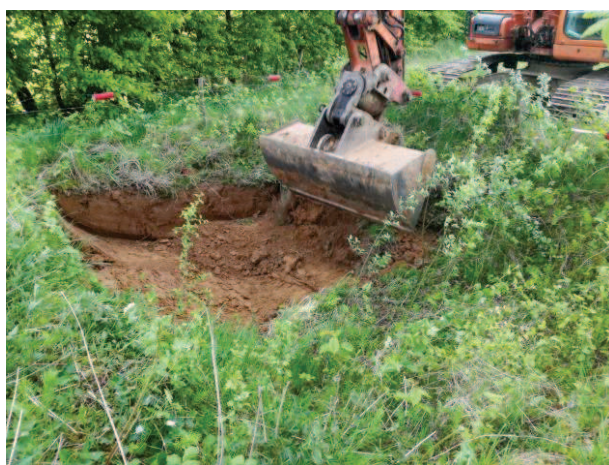
Photographie 2 : Première tranchée à l'aide d'un godet cureur
