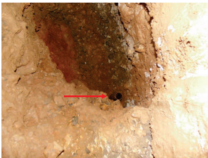
Photographie 1 : Forage d'évent (cavité 51)
