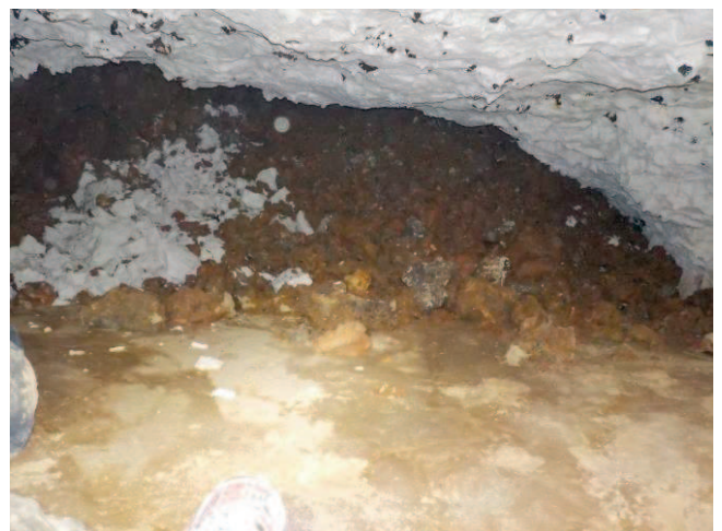
Photographie 6 : Effondrement des limons et de l'argile au sein de l'ouvrage. Nécessité de vérifier l'absence de galerie au-delà de l'effondrement
