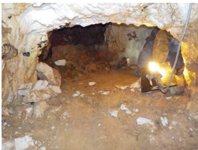
Photographie 1 : Puits et chambre de marnière
