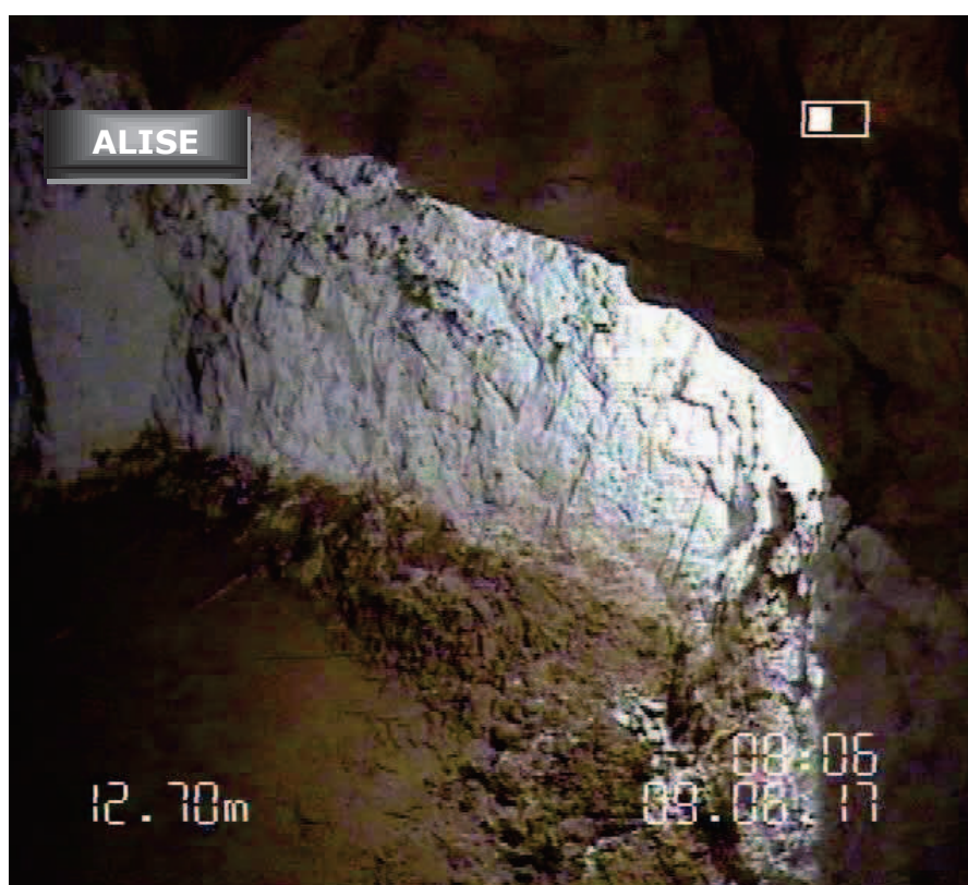
Passage caméra dans le forage SD2de l'indice n°163 avec éclairage dans SD1 : vue sur les chambres d'exploitation (1/2)
