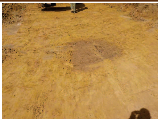
Photographie 14 : Persistance de l'anomalie circulaire (ICS 241) (Ø90cm) en fin de décapage à 3,5m
