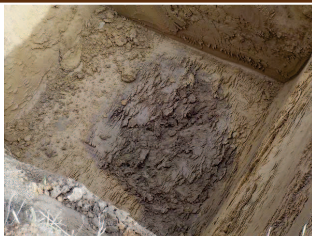
Photographie 14 : Persistance de l'anomalie circulaire (ICS 241) (Ø90cm) en fin de décapage à 3,5m
