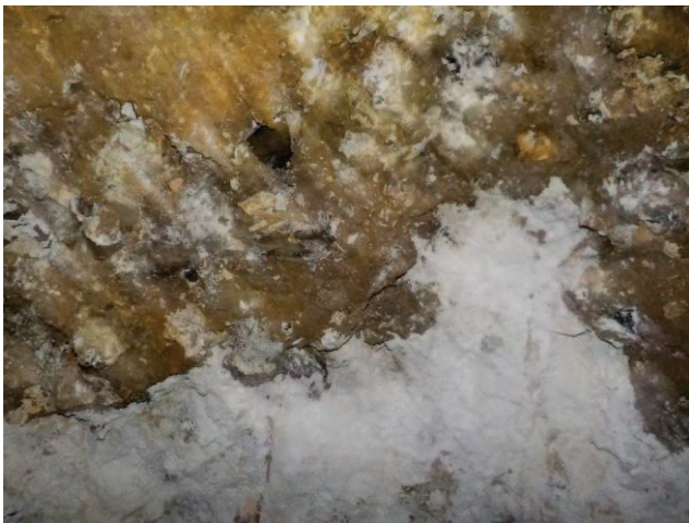
Photographie 3 : Puits recreusé le long d'un épi de marne et de l'autre côté, présence d'une racine d'argile à silex
