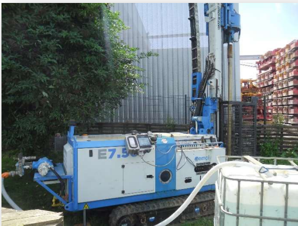
Foreuse EMCI 7.50 sur chantier
