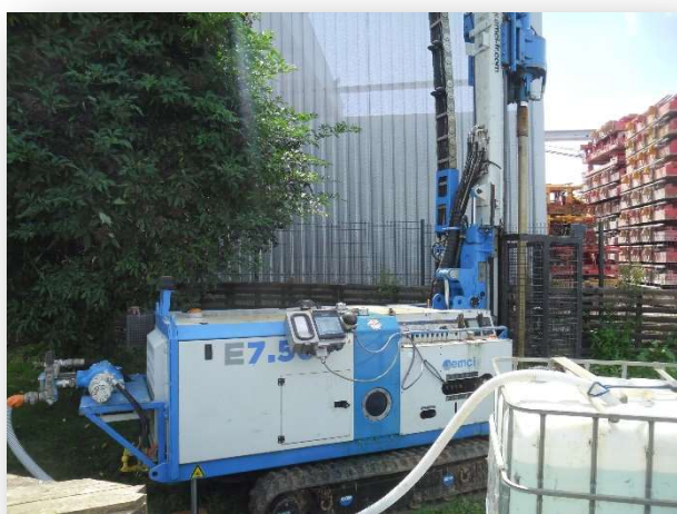
Foreuse EMCI 7.50 sur chantier
