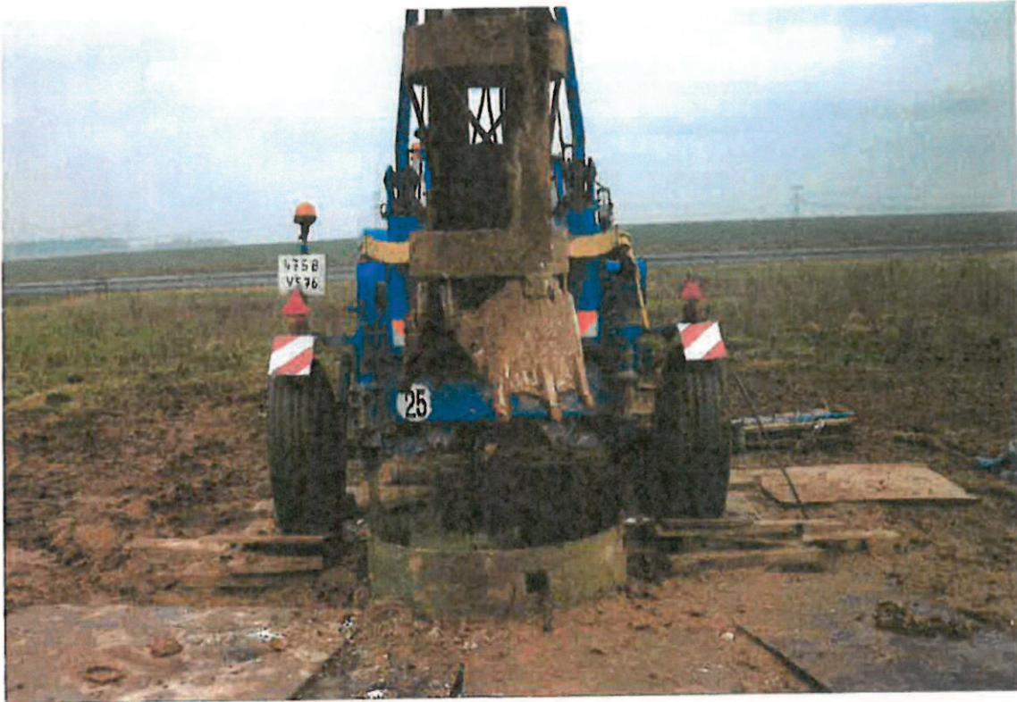
Foreuse et benne pousseuse à câble et tube acier en tête de puits
