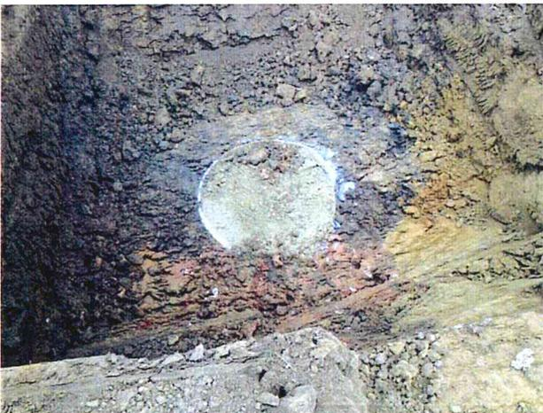
**Photographie 3 : Indice 122- Puits de marnière bétonné**
