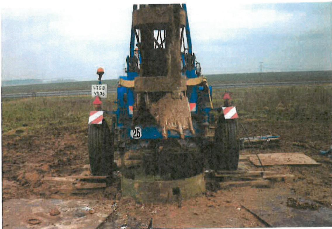
Foreuse et benne preneuse à câble et tube acier en tête de puits
