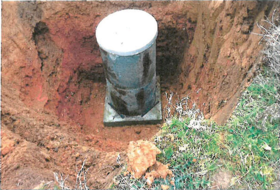
Tête de puits avec buses en béton
