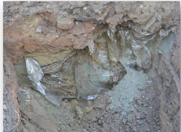
***Présence de remblais sableux fin en fond de fouille et d'un film plastique***
