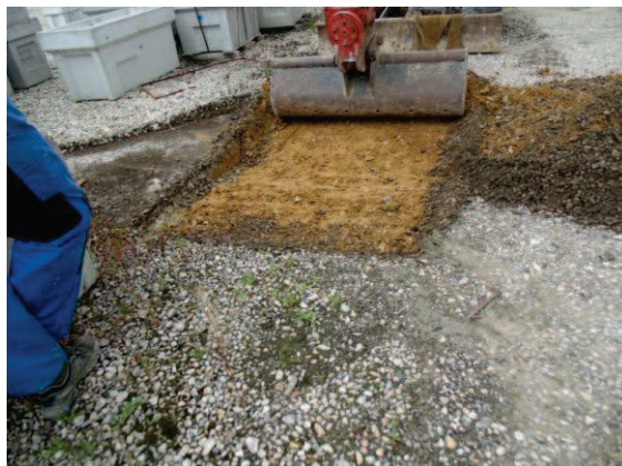
Photographie 2 : Première tranchée effectuée sur une profondeur moyenne de quelques centimètres
