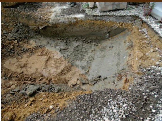
Photographie 3 : Mise en évidence de l'ancien effondrement précédemment décapé
