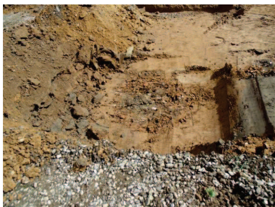
Photographie 6 : Découverte d'un puits de marnière
