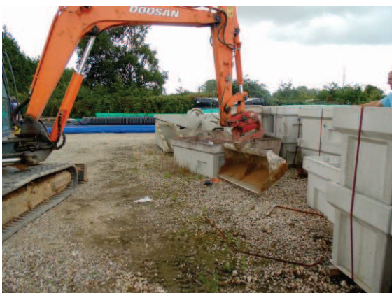
Photographie 1 : Vue d'ensemble sur le site d'étude au début du chantier
