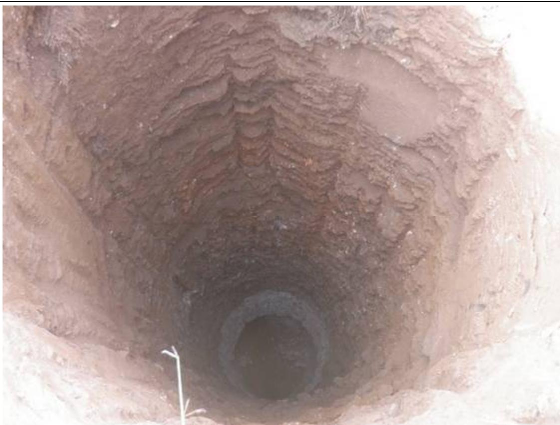
Vue de l'intérieur du puits en cours de creusement. On notera la limite argiles à silex / craie en fond de fouille
