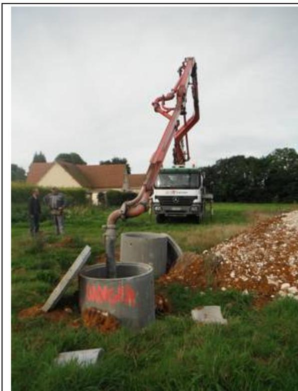
*Injection du béton au niveau d'un des puits d'accès*
