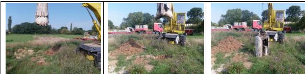
Déroulement du creusement du puits n°1 par la méthode du Havage
