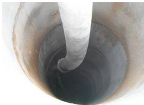
*Injection du béton au niveau d'un des puits d'accès*
