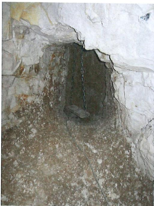
**Photographie 5 : Puits d'accès au niveau du second étage de la marnière**
