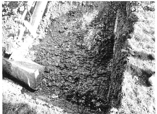
**Photographie 4 : Continuité des remblais de type « déchets » lors du surcreusement**
