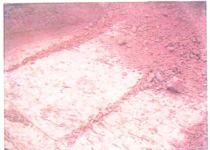
Fond de fouille à 1m de profondeur, limons en place
