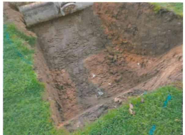
**Photographie 2 : Décapage réalisé avec un tractopelle munie d'un godet cureur**
