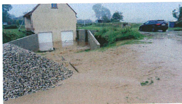
Photographie 23 : Ruissellement et inondation le jeudi 24 mai sur la propriété
