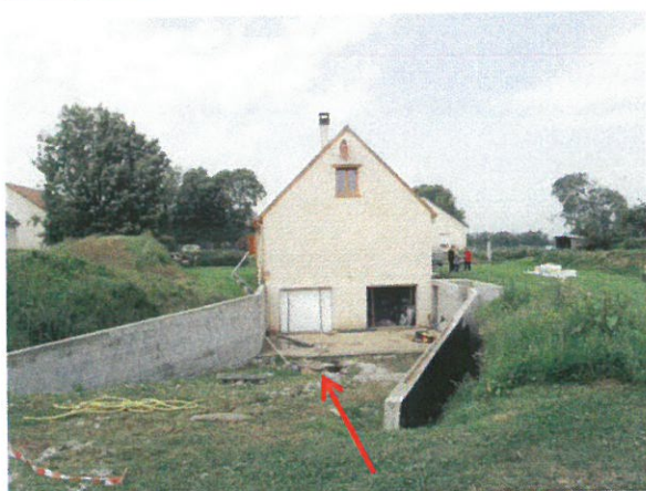
Photographie 1 : Site de l'effondrement : façade Est de l'habitation
