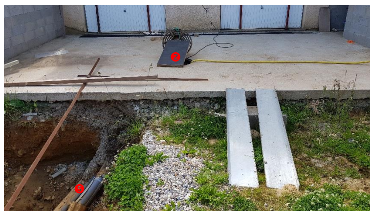
Vue sur l'ancien puisard et les tuyaux d'eau pluviale donnant sur le puisard actuel
