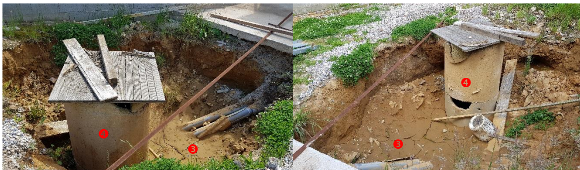
Vues de « l'entonnement » en tête du puits d'infiltration
