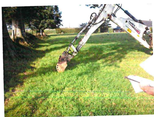
**Photographie 6 : Décapage réalisé au godet cureur**
