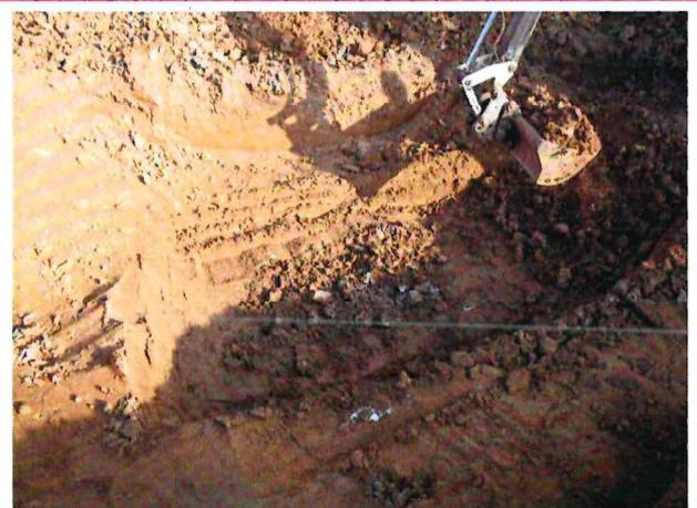
**Photographie 4 : Remblais toujours présents à 2 m de profondeur lors de l'arrêt du décapage**
