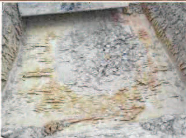
**Photographie 5 : Surcreusement de jusqu'au limon jaunâtre : Le diamètre de l'anomalie est de 80cm.**
