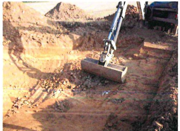
**Photographie 2 : Décapage réalisé au godet cureur**
