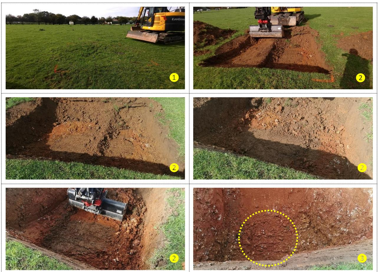
**Au vu des constats de terrain, l'anomalie identifiée correspond à un ancien puits de carrière souterraine qui a été comblé après exploitation.**
