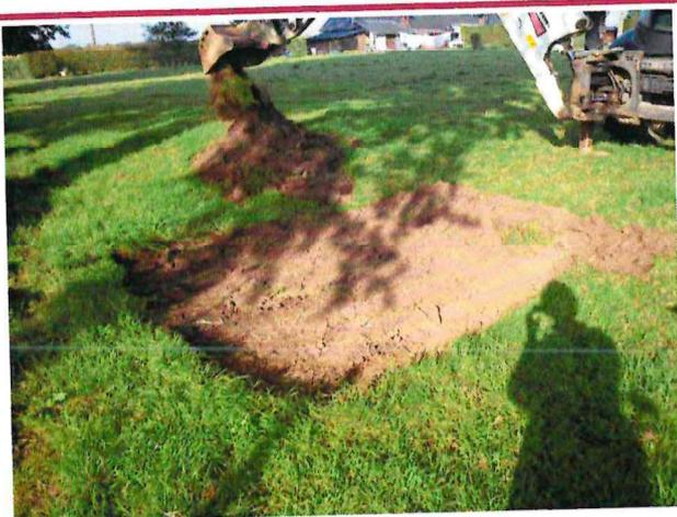
**Photographie 7 : Décapage par lames de 20 à 30 cm d'épaisseur**
