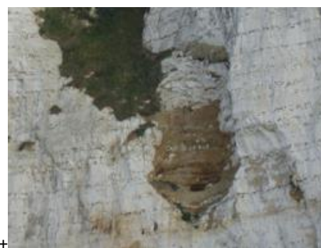
Karst obstrué visible sur la falaise
