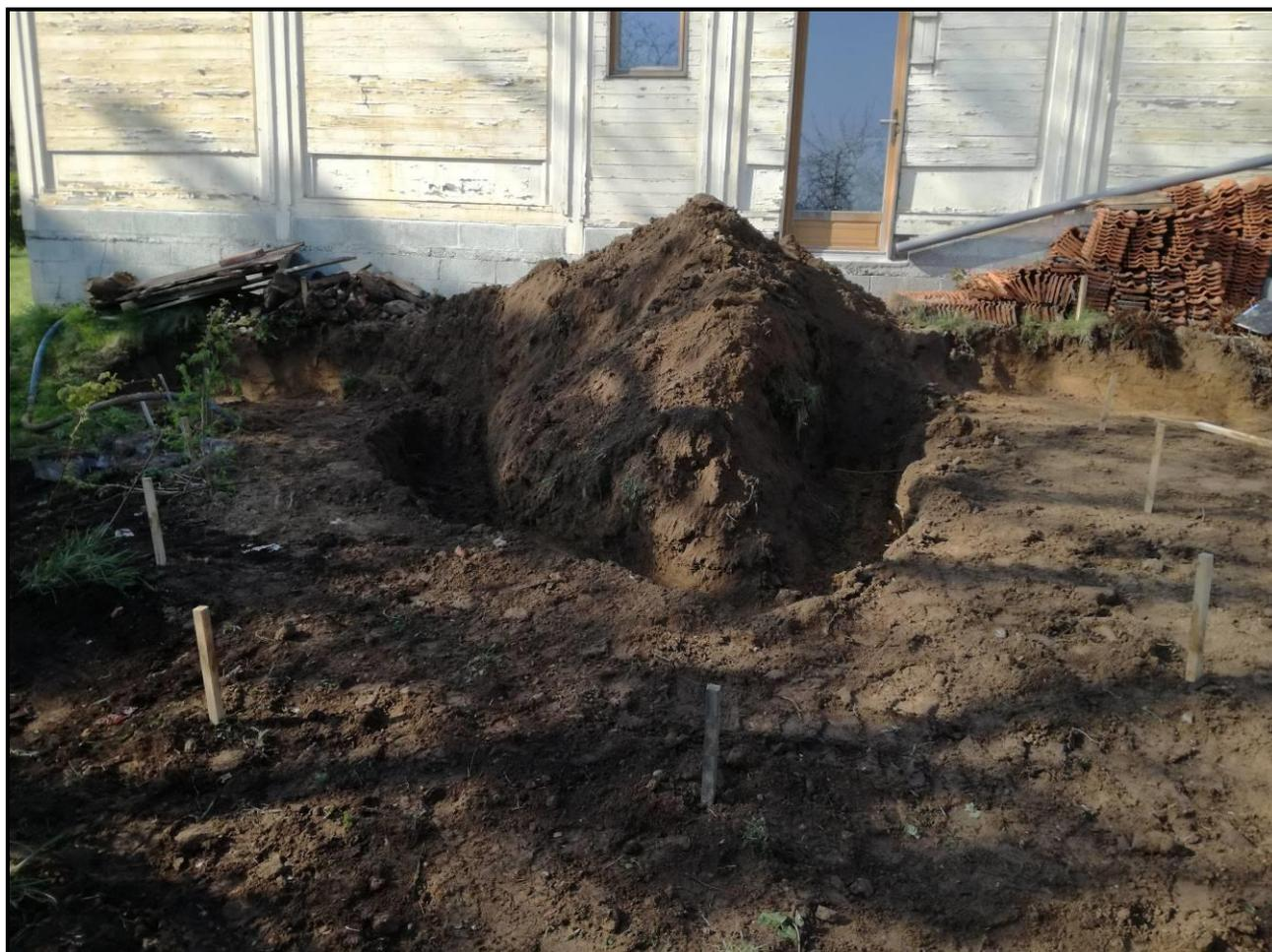
**Photographie 6 : Effondrement comblé et création d'une tranchée pour la récupération des cuttings de forages**
