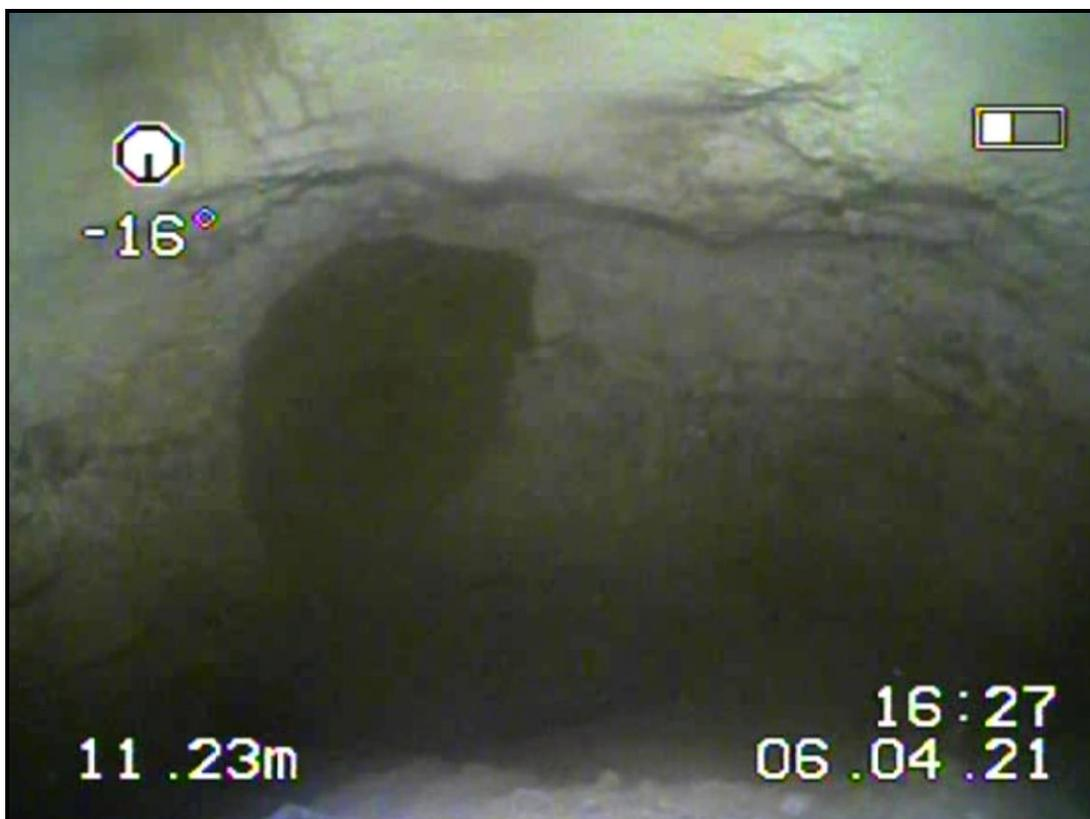
**Photographie 4 : Entrée dans la cavité, racine d'altération bien visible d'un côté de la cavité**
