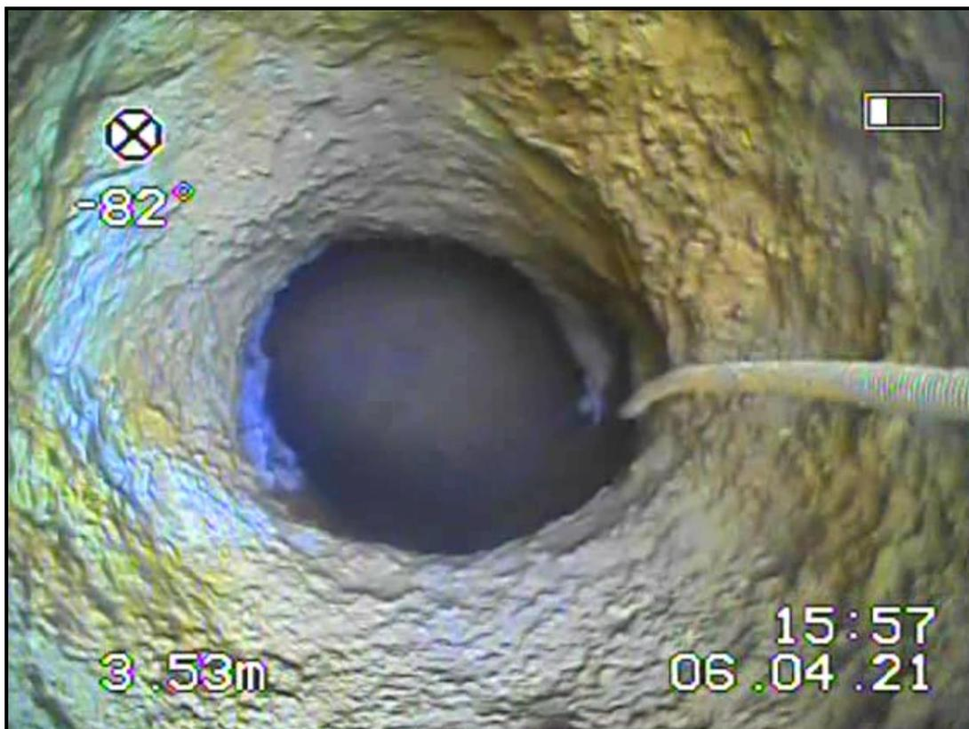
**Photographie 3 : Milieu du puits, début de l'entrée de craie visible sur la gauche du puits**
