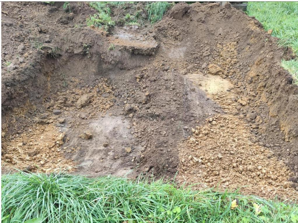
***Isolément d'une zone remblayée décomprimée au sein des formations à silex très charpentées***
