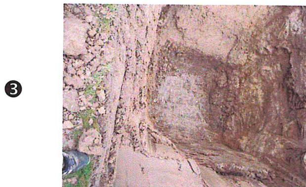
Les reconnaissances effectuées au droit de cette anomalie ont mis en évidence une zone de remblai limoneux et crayeux parfaitement circulaire de diamètre 1.2 m correspondant à un ancien puits, sans toutefois pouvoir préciser à ce stade s'il s'agit d'un puits d'accès à une ancienne exploitation souterraine.
