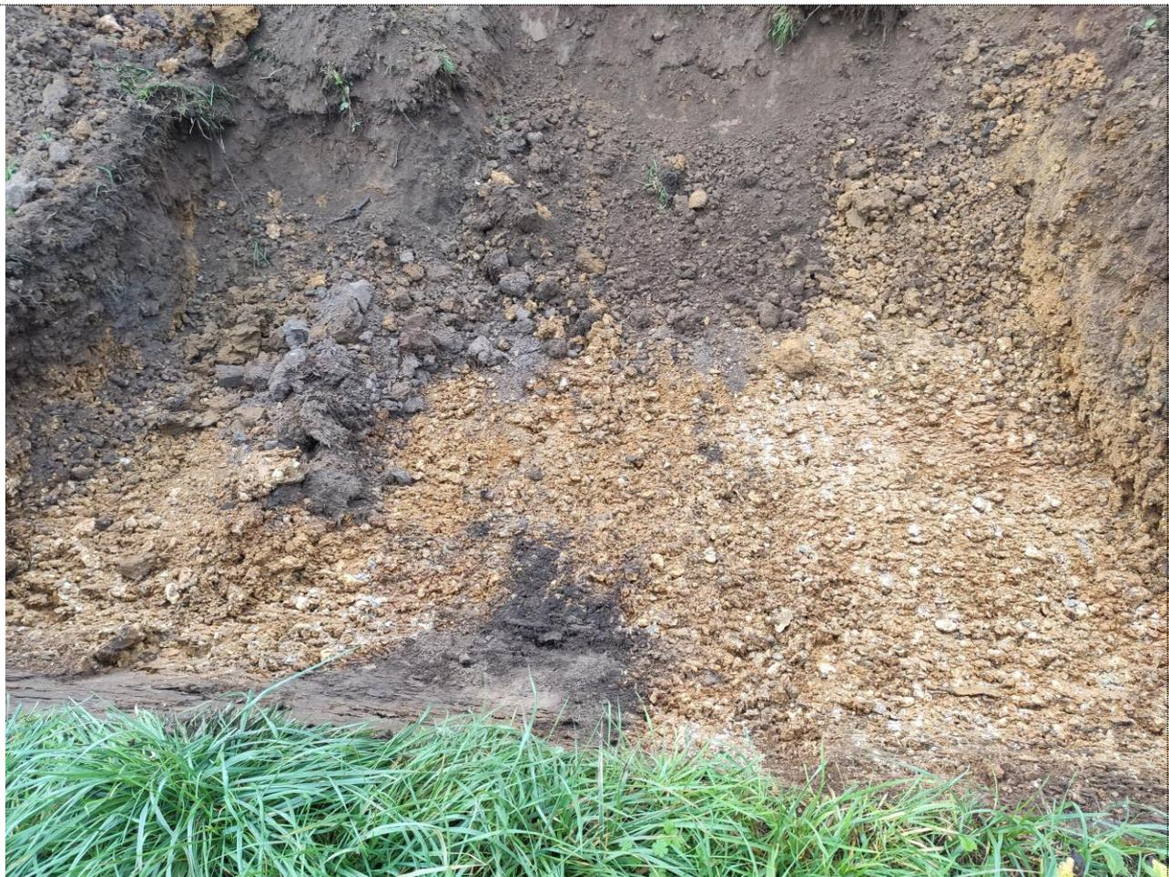
**Vue sur les argiles à silex non perturbées en fond de fouille à -1,4m/TN**
