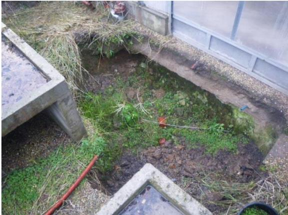
**Photographie 1 : Remblais par strate visible au nord de l'effondrement**
