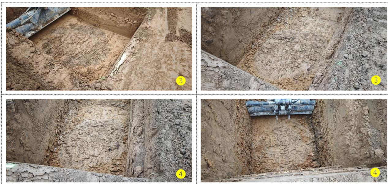
**Au vu des constats de terrain, l'anomalie identifiée correspond à un ancien puits de carrière souterraine qui a été comblé après exploitation.**
