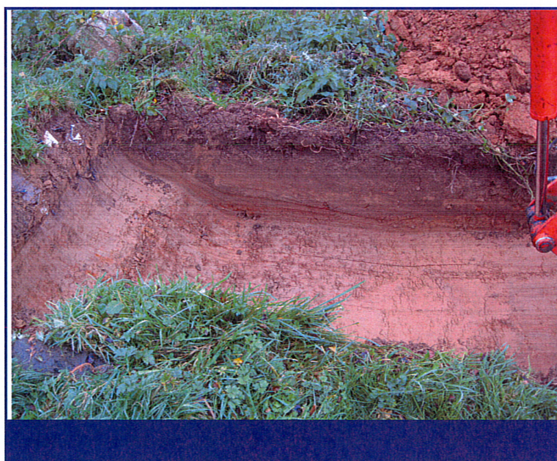
Photo 2 : Fond de fouille première tranchée à 40 centimètres de profondeur
