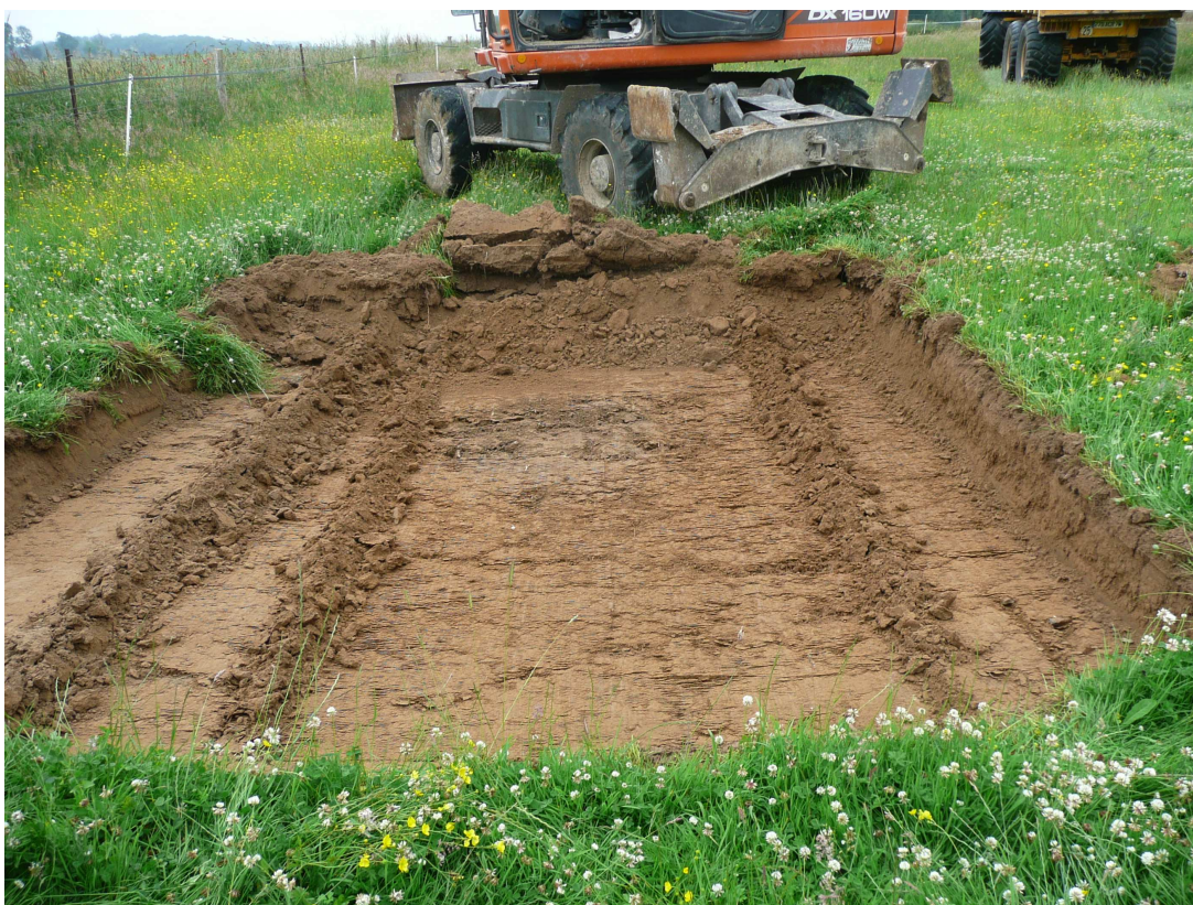
cliché 3 : décapage à 0.35m
