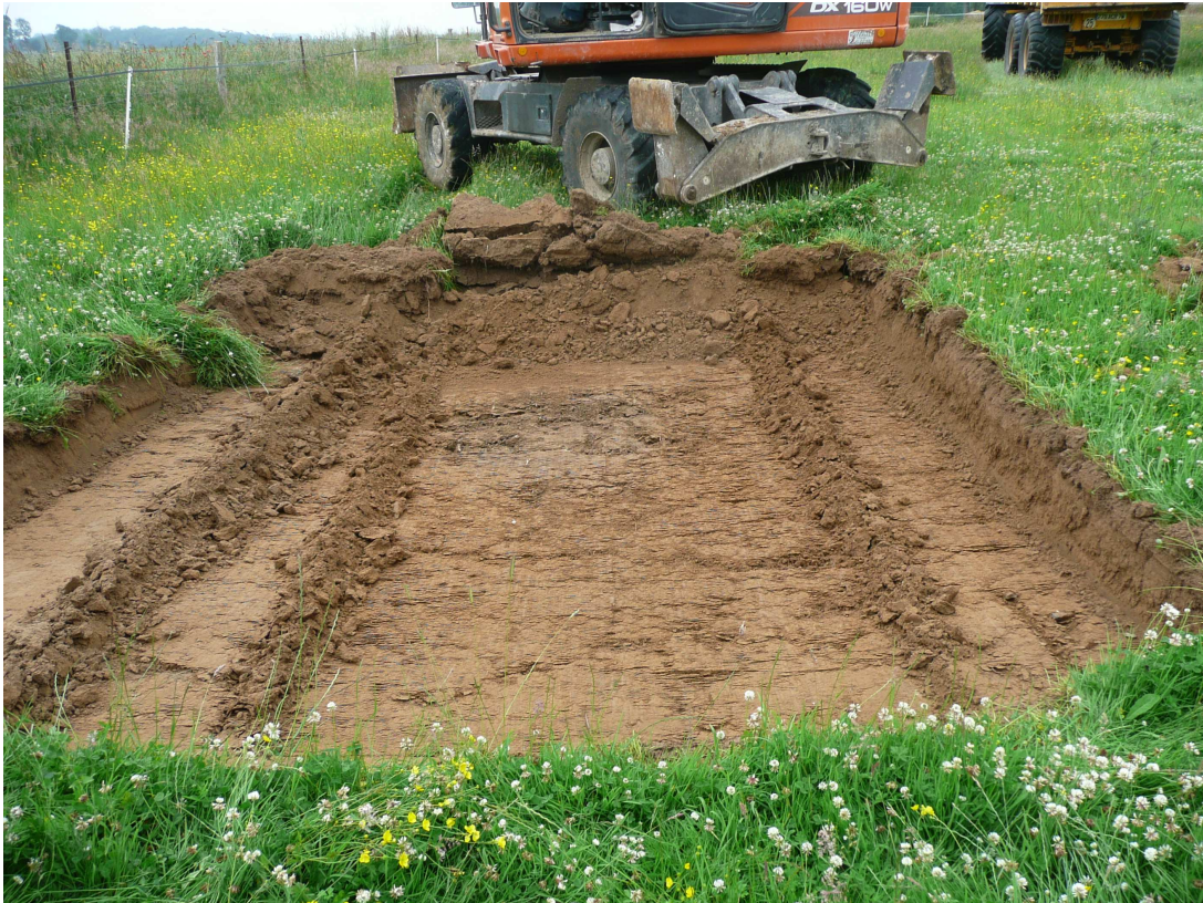
cliché 3 : décapage à 0.35m
