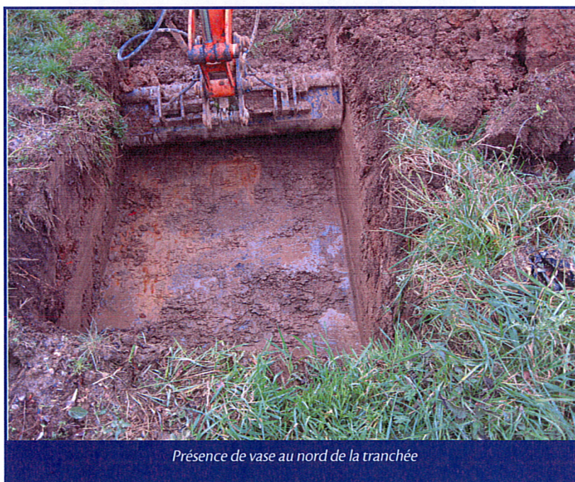
Photo 6 : Fond de fouille seconde tranchée à 70 centimètres de profondeur
