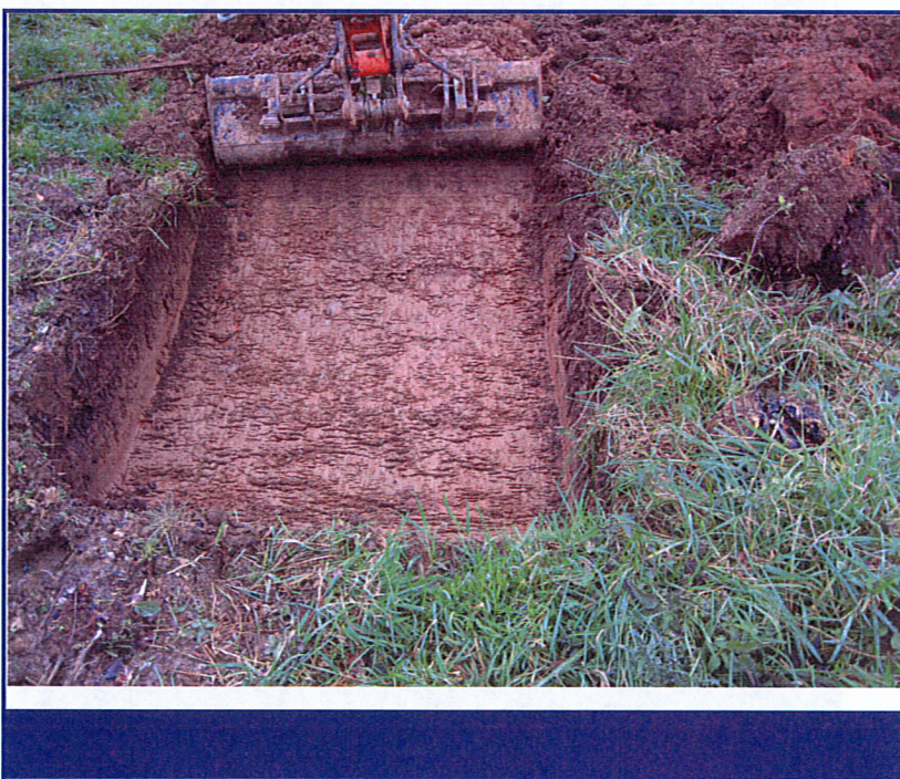
Photo 4 : Fond de fouille seconde tranchée à 30 centimètres de profondeur
