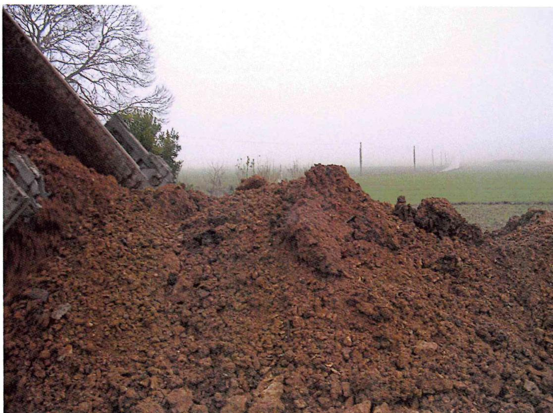
Cliché N°8. Formations argileuses à silex utilisées pour le comblement du puits.
