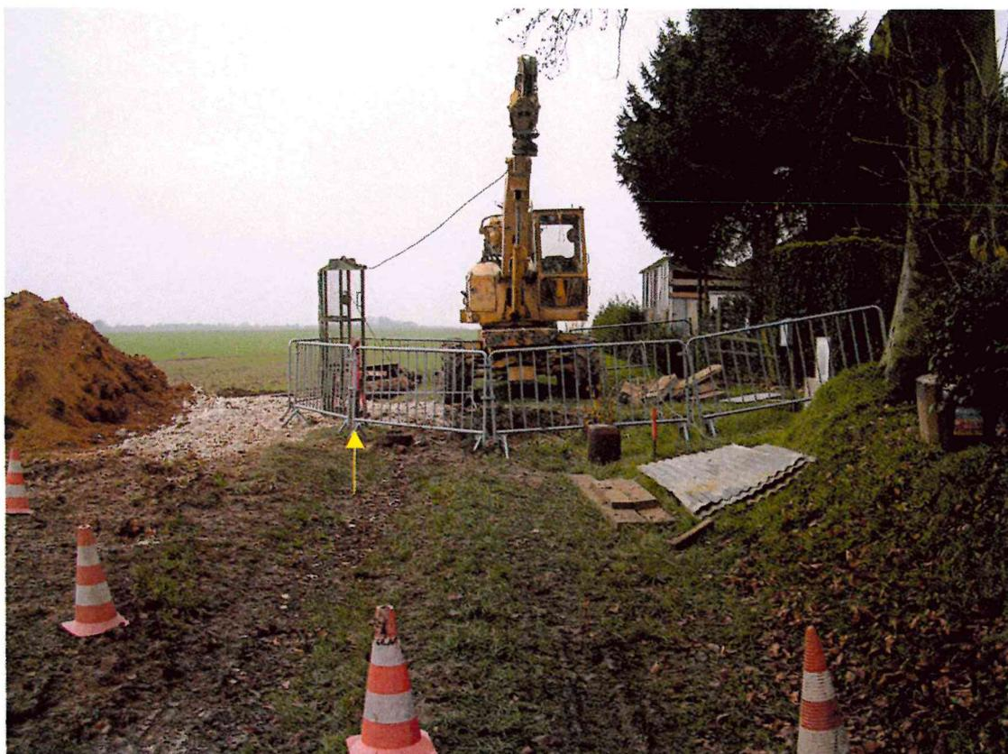
Cliché N°1. Perçage du puits au centre du chemin, la flèche indique l'emplacement du SD3 qui a rencontré un vide entre 10.40m et 11.60m.
