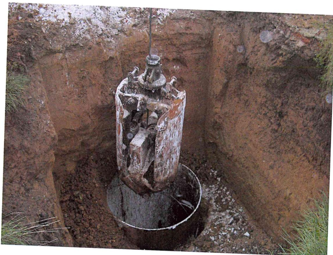
Cliché N°13. Compactage du remplissage à l'aide de la benne preneuse fermée.
