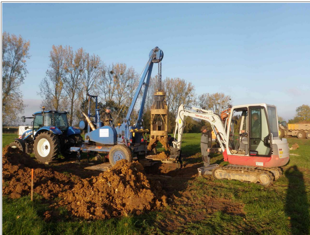
Curage en cours, entreprise DUVAL
