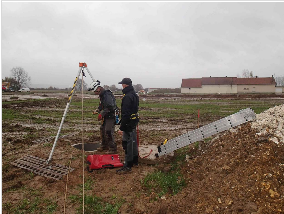
Agents du Cerema se préparant à la descente sur cordes
