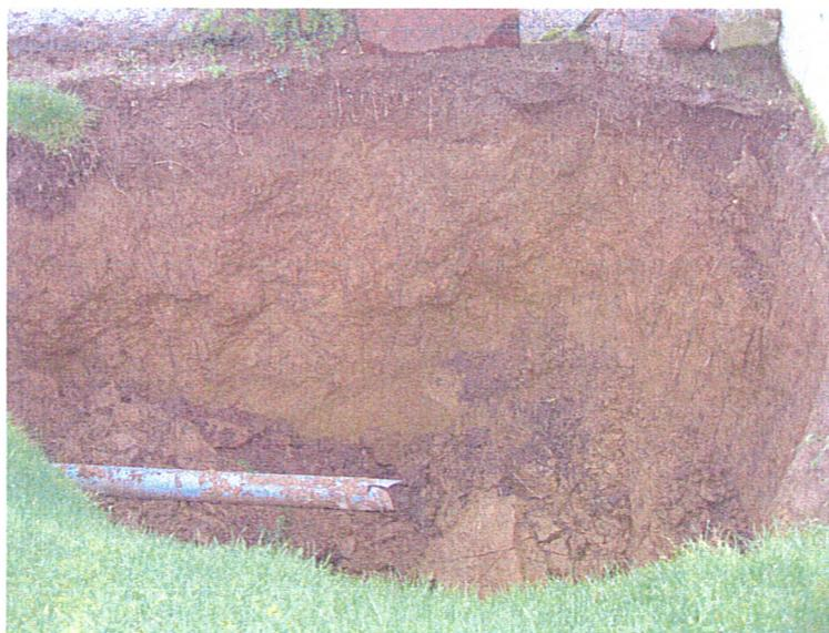
Figure 2 : Vue rapprochée de l'effondrement
