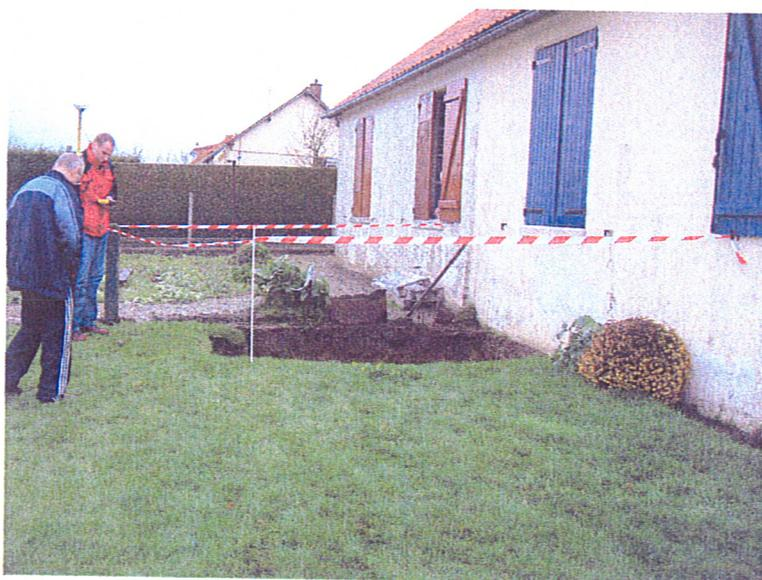
Figure 1 : Ouverture en surface de l'effondrement
