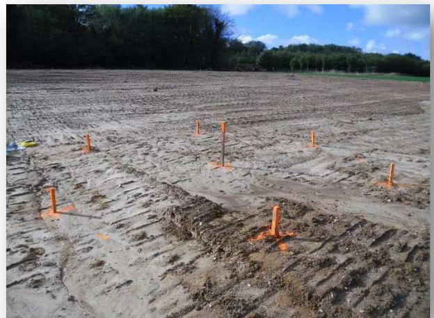
*Implantation des forages SD1 à SD7 sur l'indice IC1*
