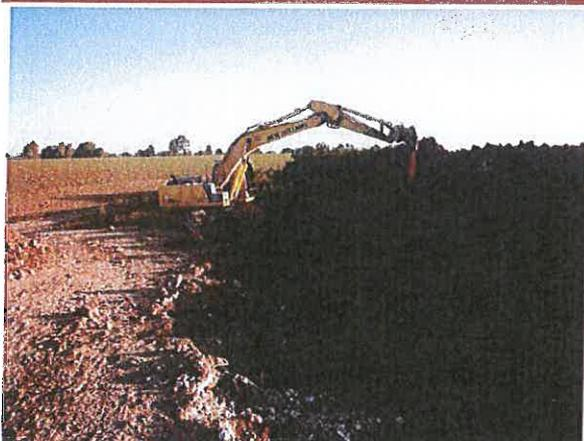
**Photographie 3 : Décapage en bandes successives par lames de 20 à 30 cm d'épaisseur**
