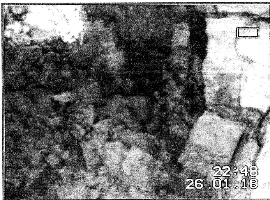
Le point lumineux visible sur cette photo correspond à une ampoule descendue dans le sondage SD5. On remarque la présence de nombreux éboulis et blocs de craie sur le sol.
