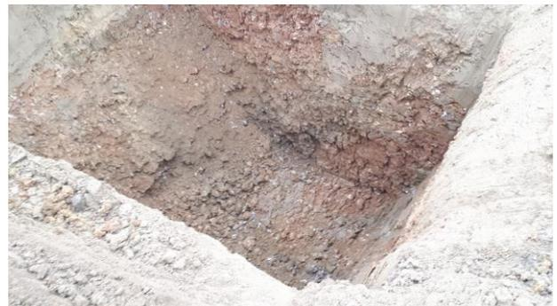
**Photographie 14 : Anomalie circulaire toujours présente en fin de décapage, vers 6,5m de profondeur**
