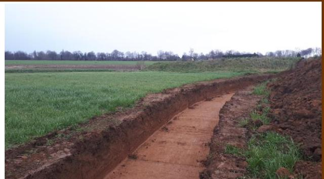
**Photographie 4 : Décapage réalisé en bandes successives**
