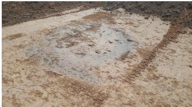
**Photographie 5 : Apparition d'une anomalie de remblais à 30cm de profondeur**
