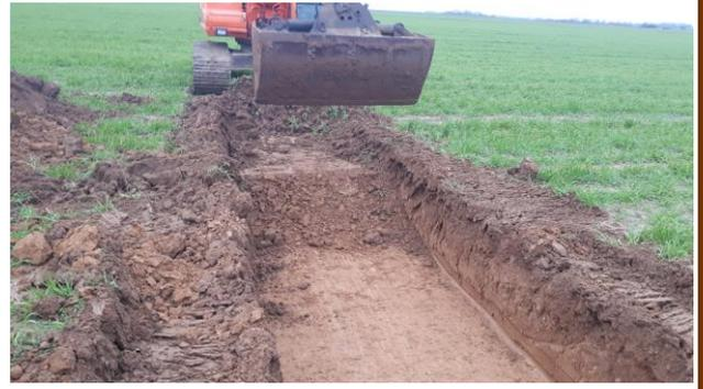
**Photographie 2 : Décapage réalisé avec une pelle munie d'un godet cureur**
