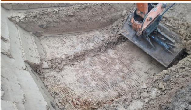
**Photographie 7 : Apparition des argiles à silex vers 2m de profondeur. Anomalie toujours présente**
