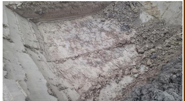
**Photographie 6 : Anomalie de remblais se poursuivant en profondeur (1,5m)**
