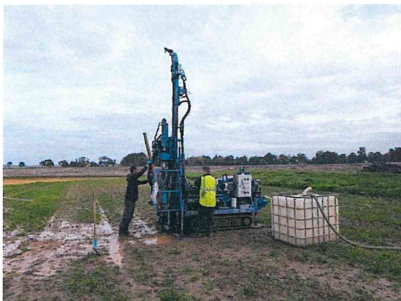
Foreuse SEDIDRILL SD200 sur chantier
