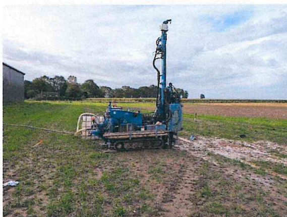
Foreuse SEDIDRILL SD200 sur chantier
