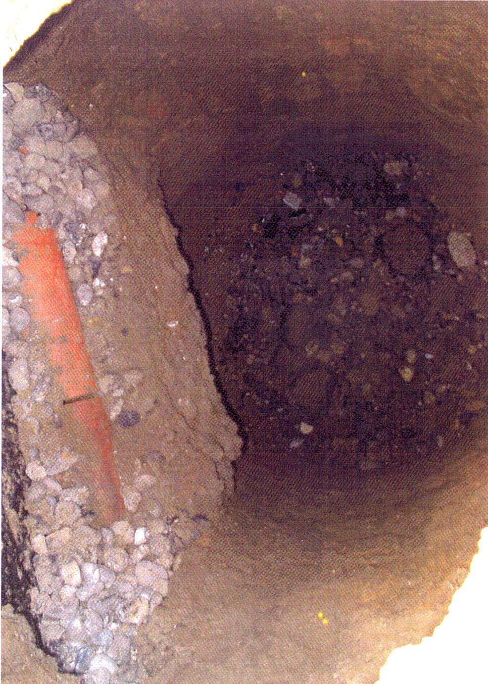
photo n° 2 : vue de l'effondrement, on peut observer les fondations de la tribune en haut de la photo.
