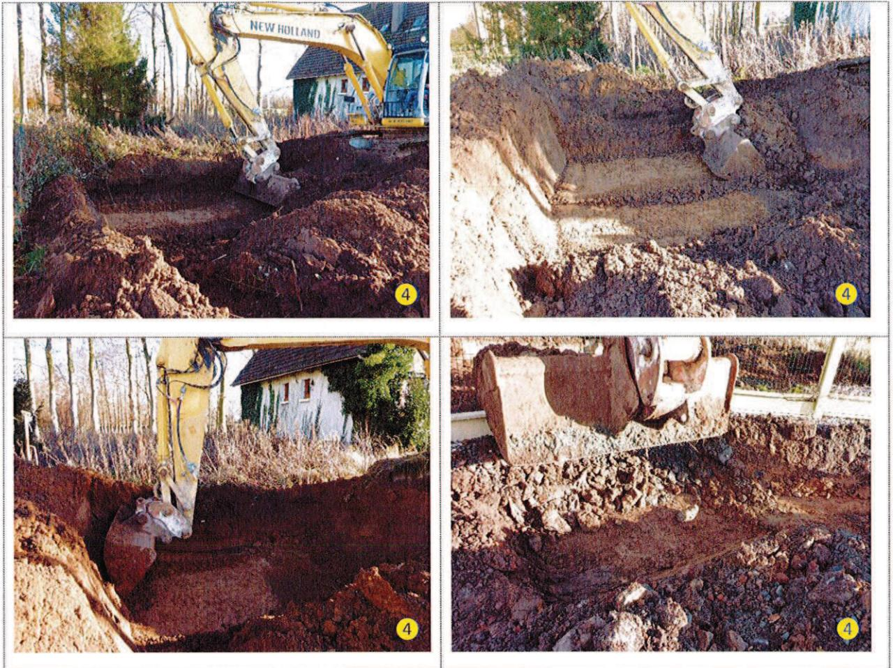
Aucune anomalie (fantôme de puits, zone remblayée profonde, zone décomprimée...) pouvant être en relation avec une ancienne cavité souterraine d'origine anthropique n'a été observée au droit de cette zone investiguée.
