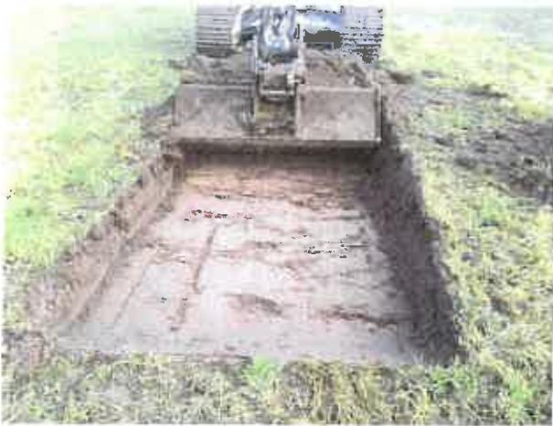
**Photographie 1 : Décapage par lames de 0,20 à 0,30m au godet cureur**
