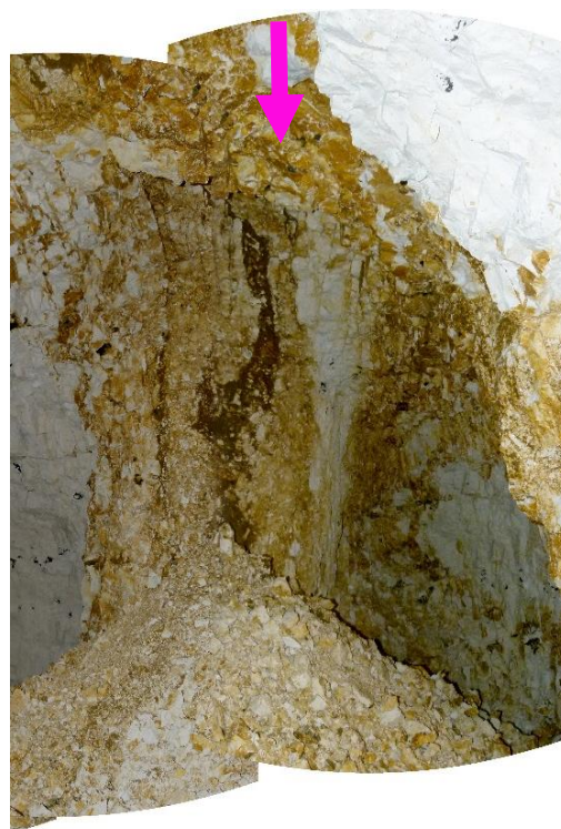
Faïlle observée dans une marnière (Belmesnil – Crédit photo : explor-e)
