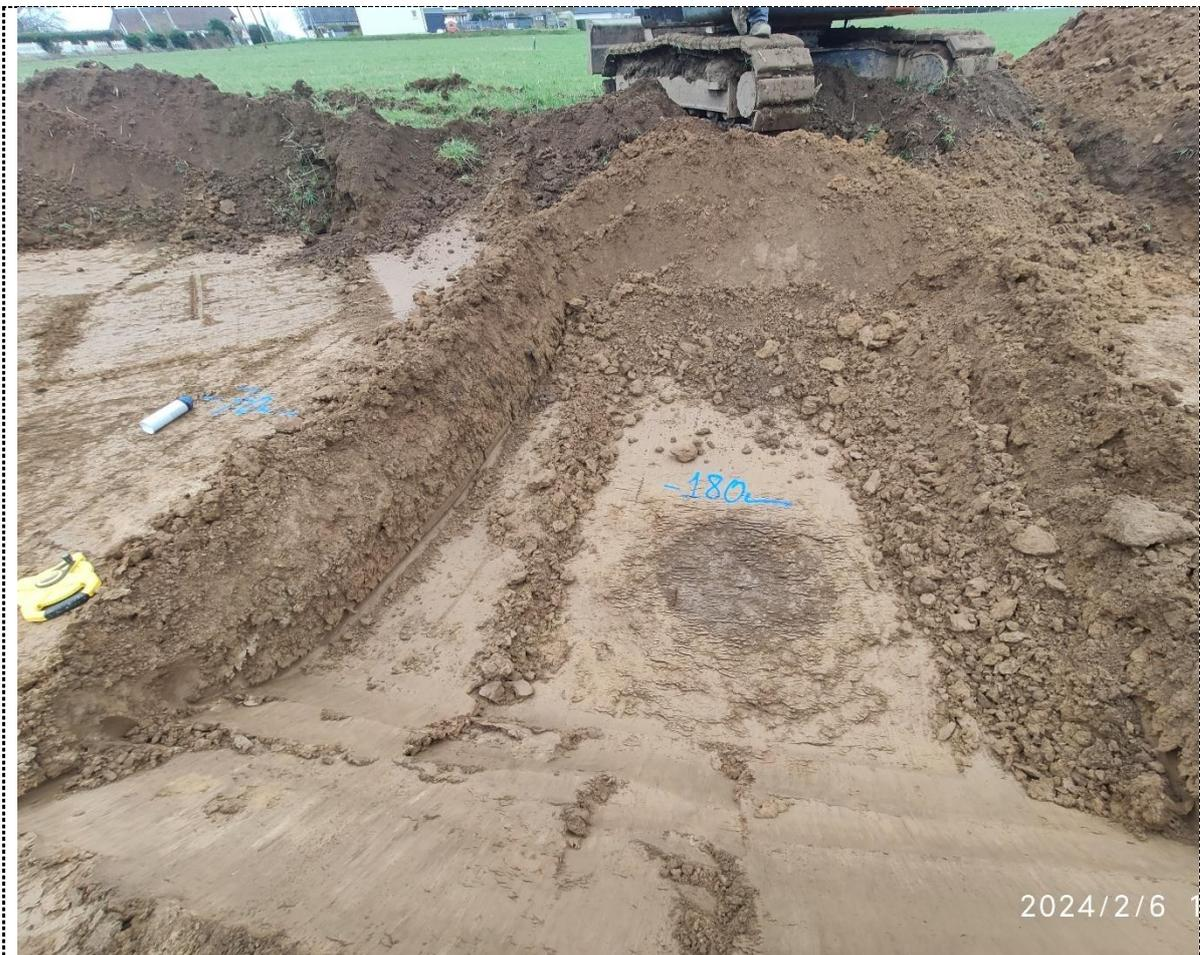
*Persistance de l'anomalie à -1.8m de profondeur (0.8m de diamètre – arrêt du décapage)*
