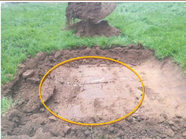
**Photographie 3 : Présence d'une anomalie dès 20cm de profondeur**
