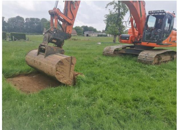
**Photographie 2 : Décapage réalisé au godet cureur par lames de 20 à 30cm**
