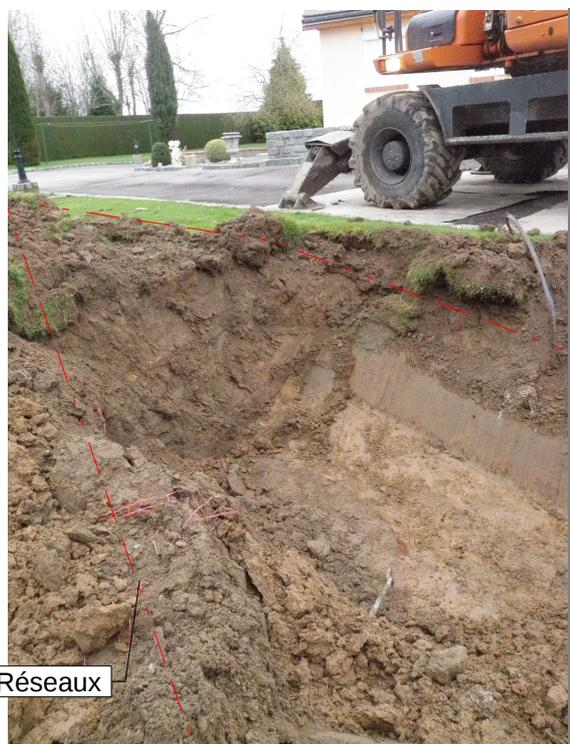
*Illustration 1: Disposition des réseaux autour du sondage à la pelle*
