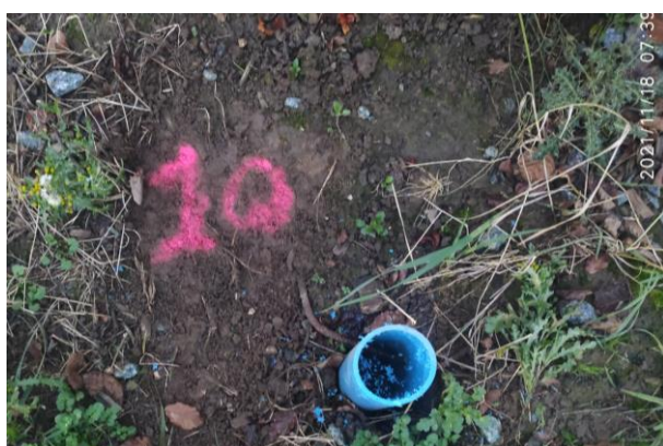
SD10 avant injection du coulis
