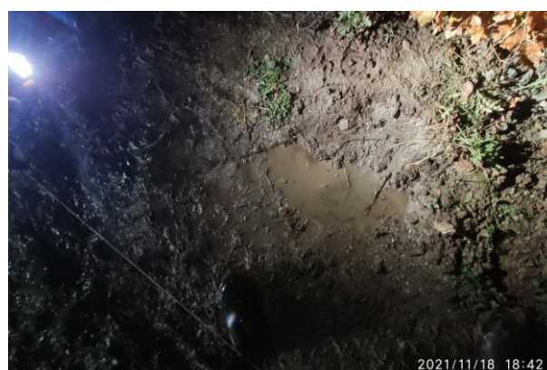
SD10 après injection du coulis
