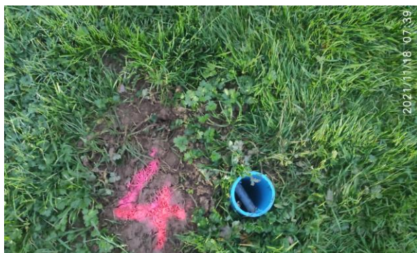
SD04 avant injection du coulis
