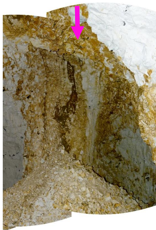
Faille observée dans une marnière (Belmesnil – Crédit photo : explor-e)
